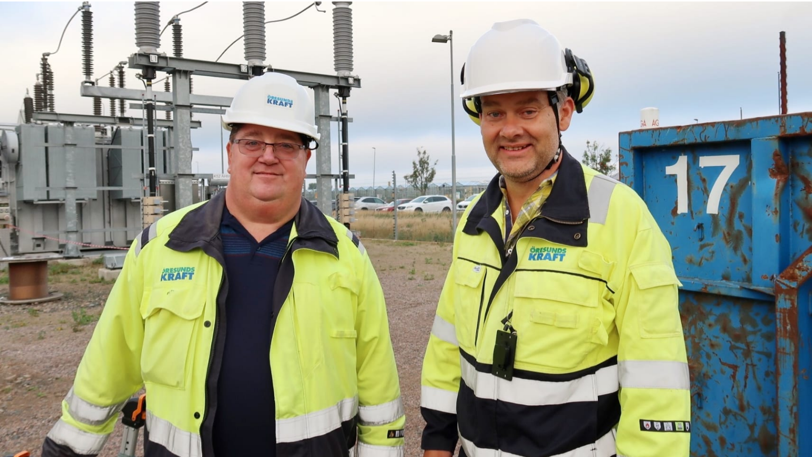
#tillsammansför17, Peter Johansson och Magnus Olofsson projektleder förstärkningen och moderniseringen av Ängelholms elnät. (Bild från stationen vid Åkerslund. Foto:Lovisa Lundström)
